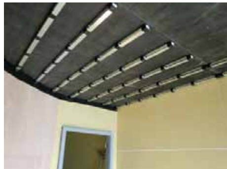
天井：音シャットフレーム 303mm ピッチで施工
