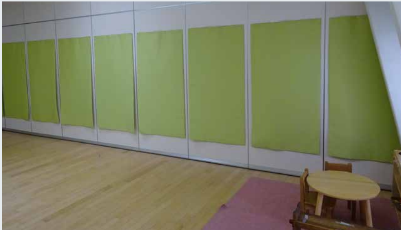
吸音材施工前
